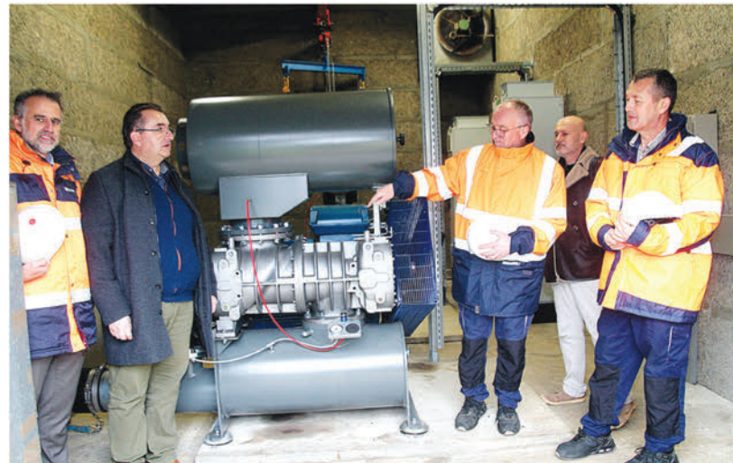
Le projecteur d'air dans le bassin d'épuration a été changé cet hiver.
