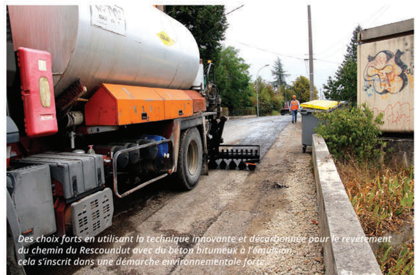
Lors des premières pas du chantier du chemin du Rescoundut cet automne.
