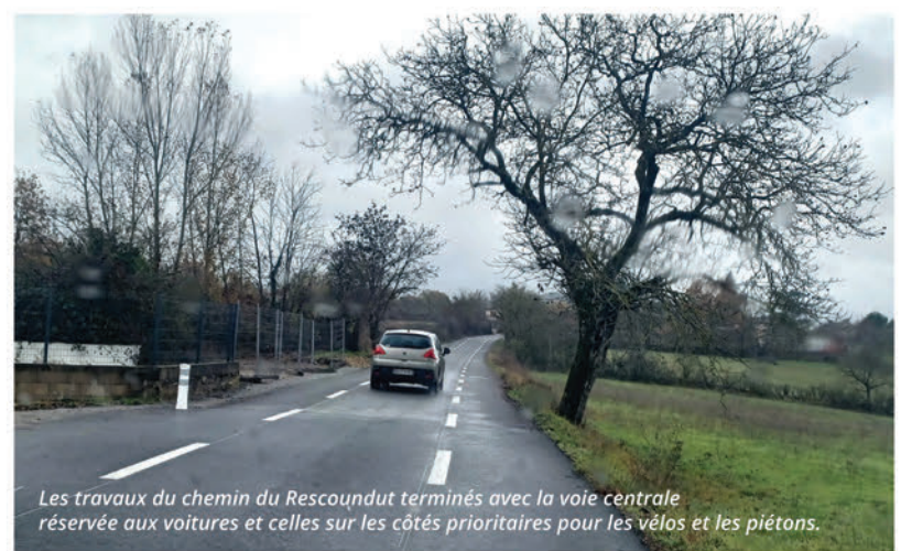
Des choix forts en utilisant la technique innovante et décarbonnée pour le revêtement du chemin du Rescoundut avec du béton bitumeux à l'émulsion, cela s'inscrit dans une démarche environnementale forte.
