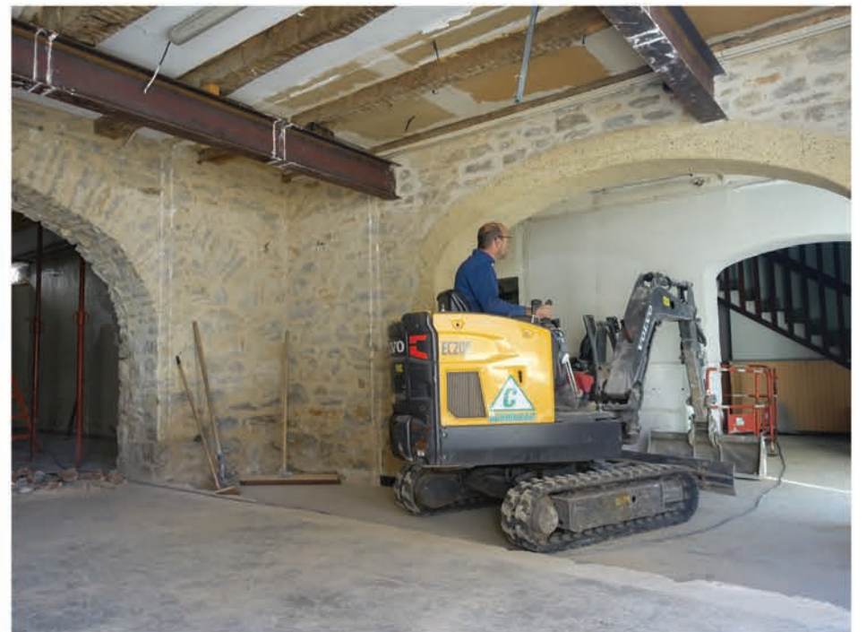
Le chantier de la maison des jeunes citoyens a débuté mi-novembre 2022.
