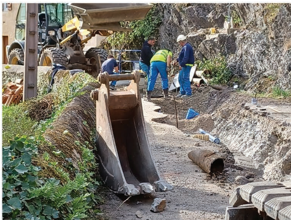
Le chantier d'assainissement, lancé en cette fin octobre 2022 va s'échelonner sur six mois.
