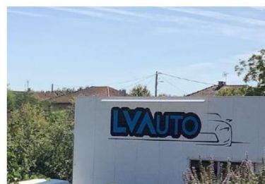
Enseigne parallèle au mur avec une rampe lumineuse, Villeneuve
