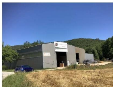
Enseigne (illégale) présente le long de la RD47 en entrée d'agglomération de Montels
